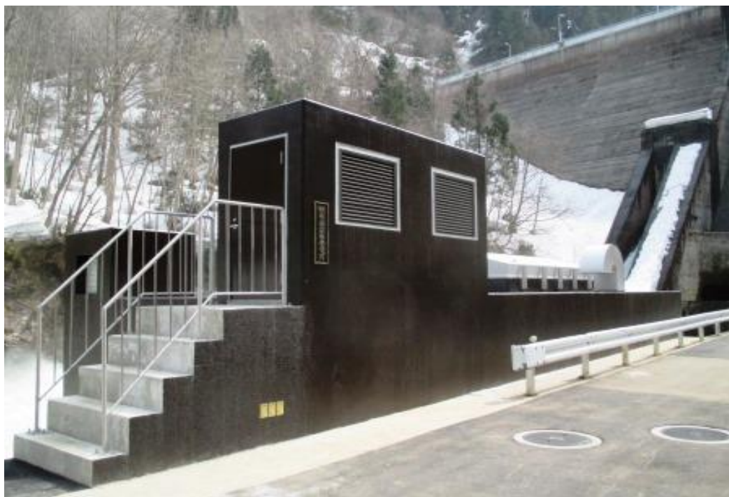
秋田県萩形発電所（上小阿仁村）（出力450kW）
